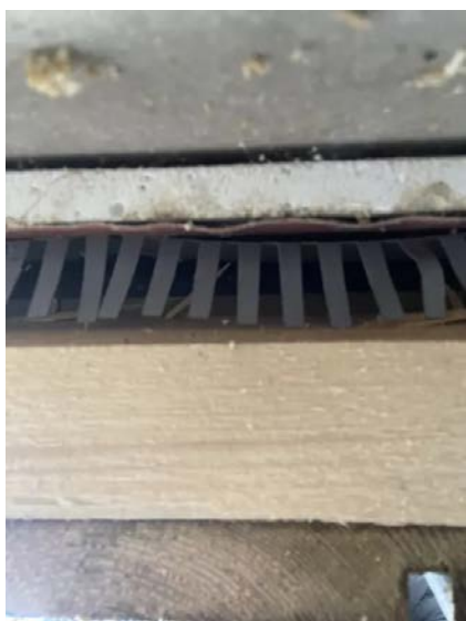
Lufting og musetetting bak kledning.
