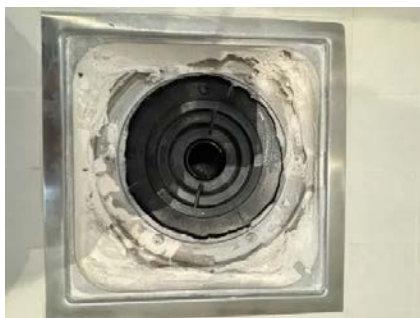
Det er klemt tettesjikt i sluk.
