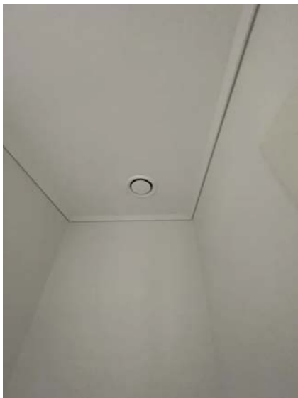
Mekanisk avtrekk i forbindelse med balansert ventilasjon.
