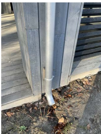
Det er montert utkast på nedløpsrør.
