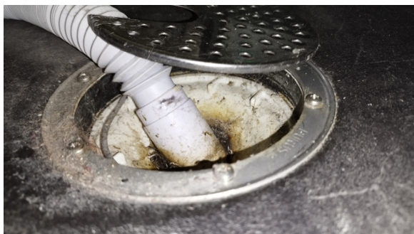
Kontroll av sluken.
