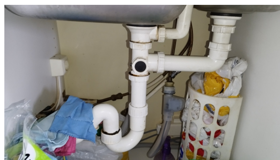
Kontroll av røropplegget.
