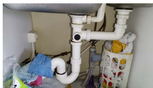
Kontroll av røropplegget.
