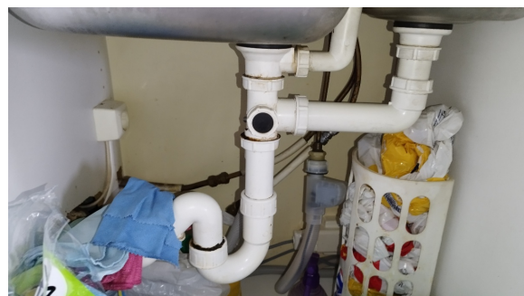
Kontroll av røropplegget.
