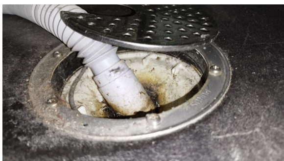
Kontroll av sluken.
