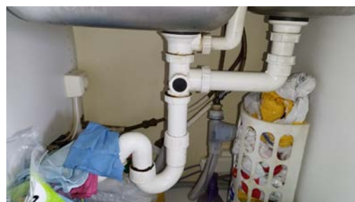
Kontroll av røropplegget.
