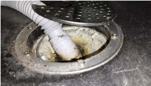
Kontroll av sluken.
