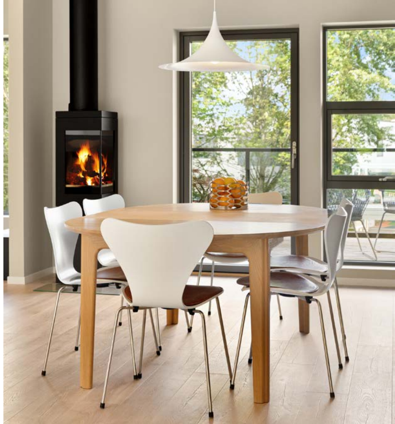
Varmepumpe luft til luft, montert i 2025
