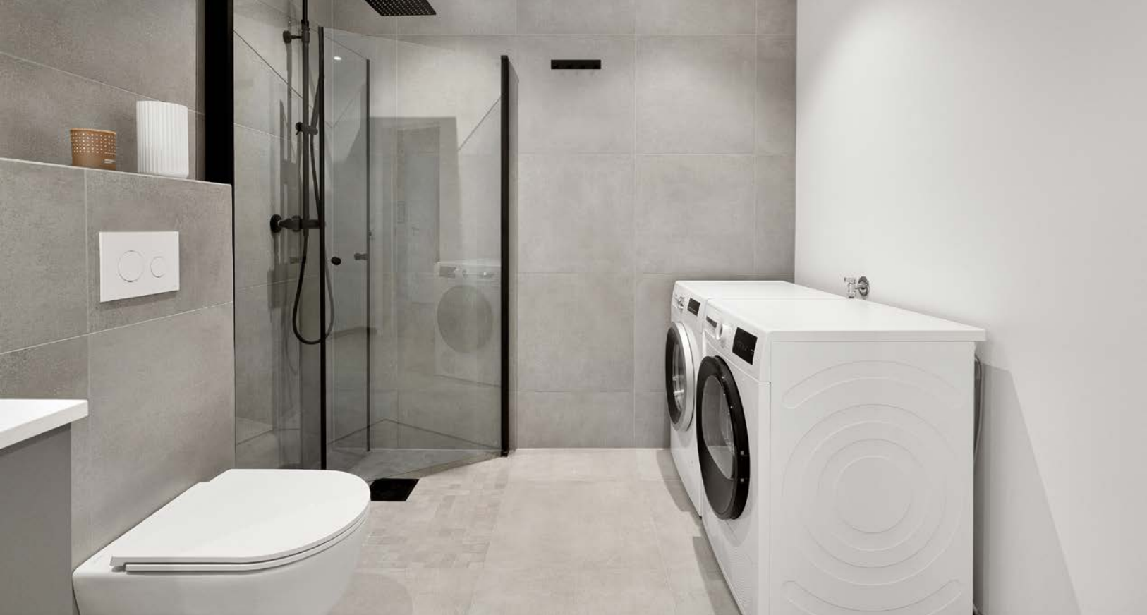
To pene bad i 1. etasje med store fliser på gulv og vegg i dusj nisjen/omliggende vegghengt toalett.
