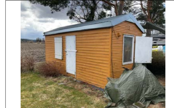
Brakkebygning på eiendommen som vurderes til å ha ingen verdi.
