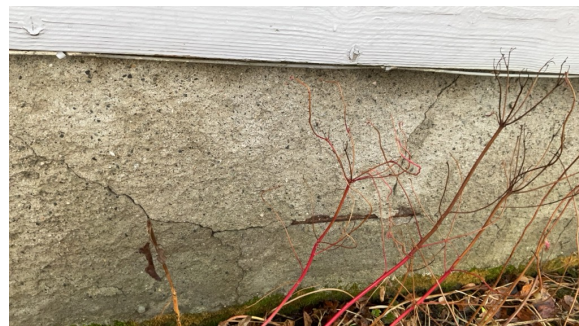
Blottlagt armering.
