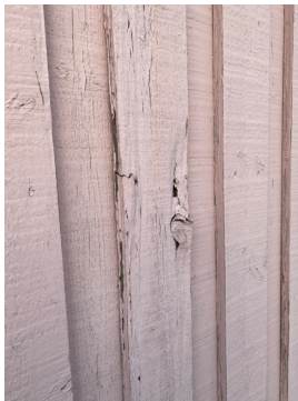
Råteskadd/væroppsprukket kledning.
