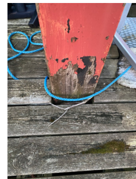
Råteskader i dør og luke til krypkjeller.
