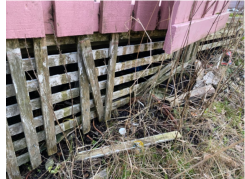
Råteskadet kledning.
