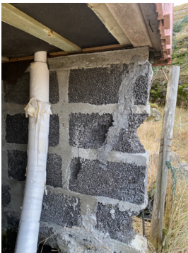
Skjevheter, skader og svekkelser i mur.
