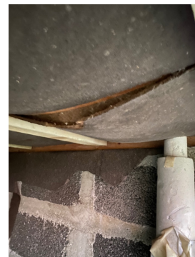
Glippe mellom plater må utbedres.
