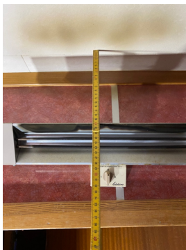
Avstand fra stråleovn til tak bør økes til min. 30 cm.
