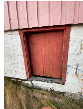
Råteskader i dør og luke til krypkjeller.
