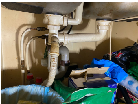
kontroll av røropplegget.
