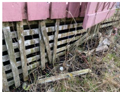
Råteskadet kledning.
