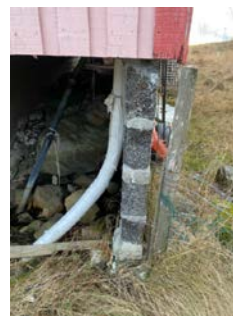
Underdimensjonert mur i leca, Skjevheter og riss/sprekker i muren.
