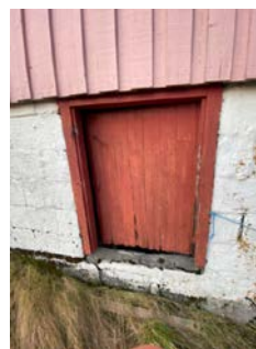
Råteskader i dør og luke til krypkjeller.
