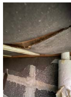
Glippe mellom plater må utbedres.
