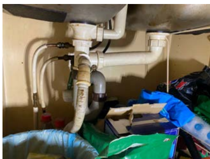
Kontroll av røropplegget.
