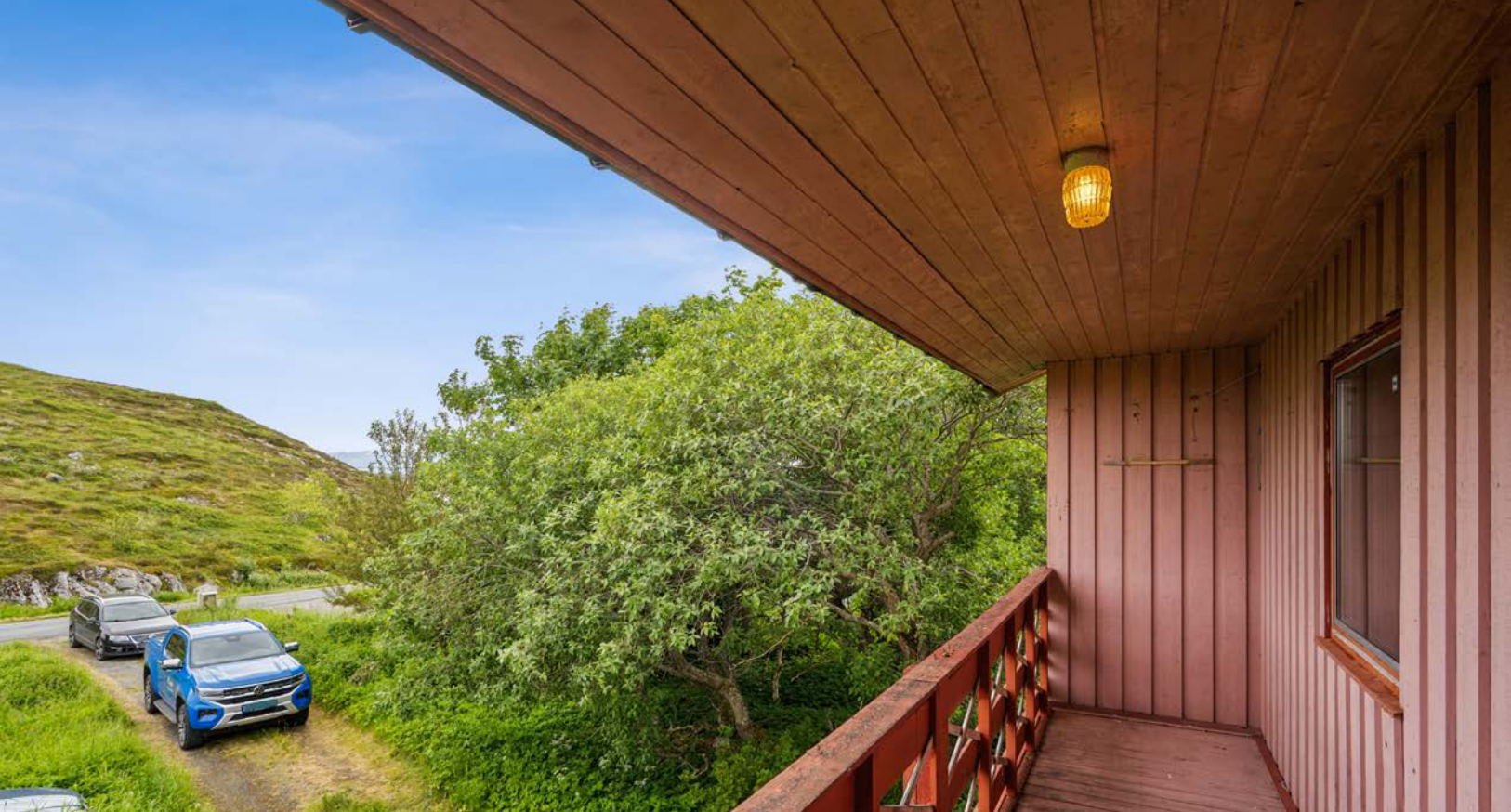
Altan med adkomst fra stuen
