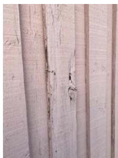
Råteskadd/værøppsprukket kledning.
