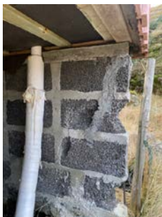
Skjevheter, skader og svekkelser i mur.
