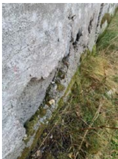
Skjevheter, skader og svekkelser i mur.
