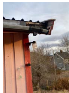
Taket mangler nedløpsrør, beslag fra tak til renne mangler.
