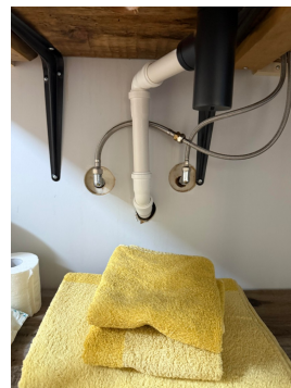
Bilde viser utette gjennomføringer under vasken.
