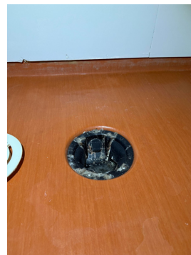
Bilde viser utette gjennomføringer under vasken.
