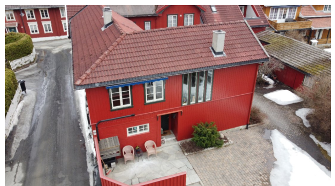
Bilde av takfalte
