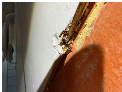
Bilde viser undersiden av våtromplate i dusjsonen
