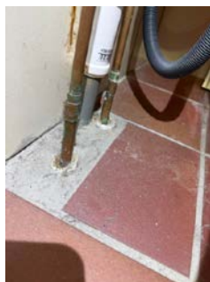
Bildet viser rørgjennomføringer uten teg til membran, tetting.
