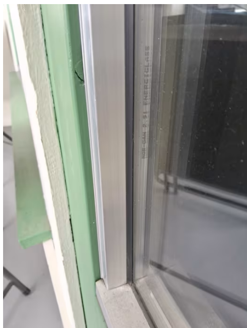
Vinduer og balkongdør i leiligheten har to-lags energiglass fra 1991.
