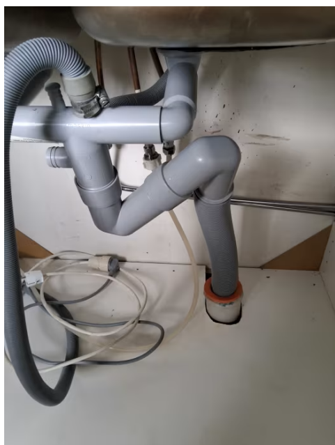
Leiligheten har synlige avløpsrør av plast.
