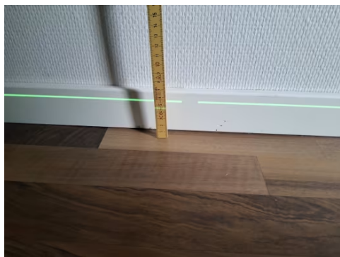
Etasjeskillet er kontrollert med nivelleringslaser.
