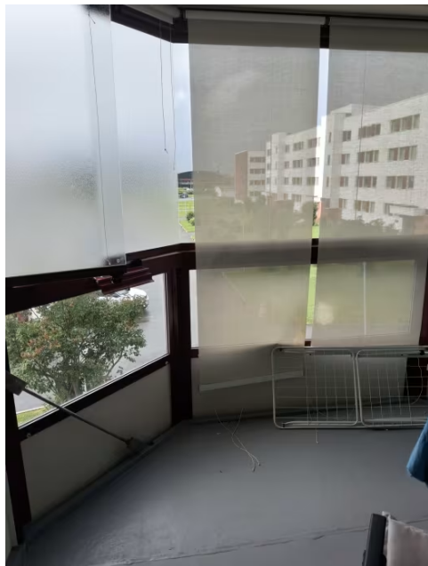
Oversiktsbilde innglasset balkong.
