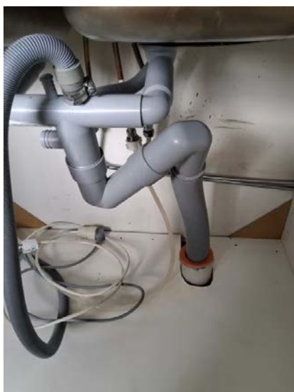
Leiligheten har synlige avløpsrør av plast.
