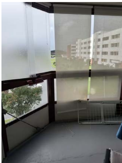
Oversiktsbilde innglasset balkong.
