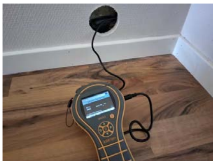
Bilde fra fuktmåling i veggkonstruksjon tilstøtende våtsone.
