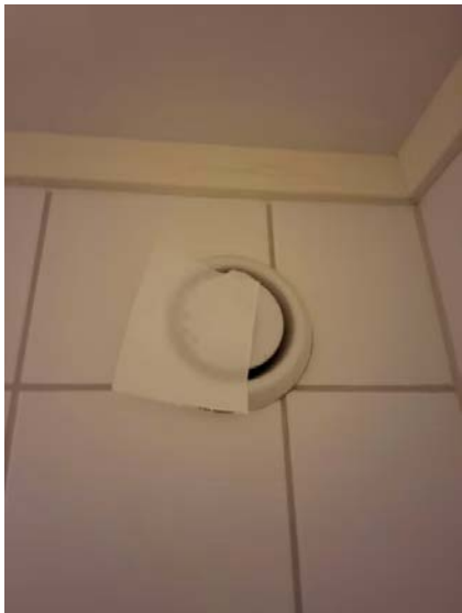
Avtrekkseffekt er testet med papir.
