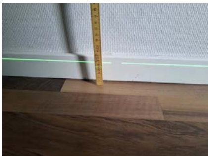
Etasjeskillet er kontrollert med nivelleringslaser.
