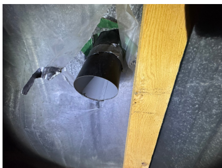
Utett gjennomføring.
