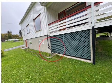
Takrennedløp som er avsluttet over terrenget.
