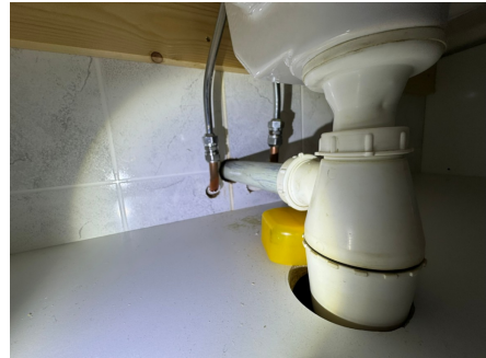
Utette rørgjennomføringer.
