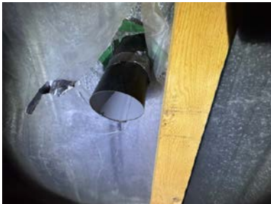
Utett gjennomføring.
