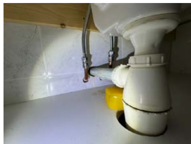
Utette rørgjennomføringer.
