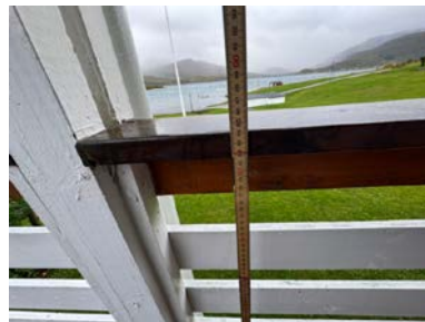
Rekkverkshøyden.
