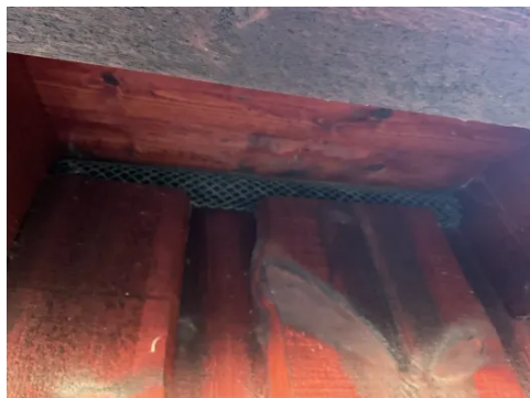
Luftespalter ved raft utført med netlon
