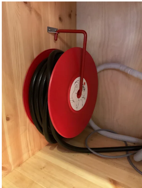
Montert brannslange i benkeskap inne på kjøkken
