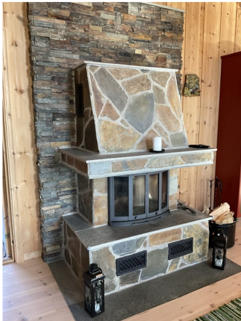
Ildsted med peisinnsats i murt omramming
