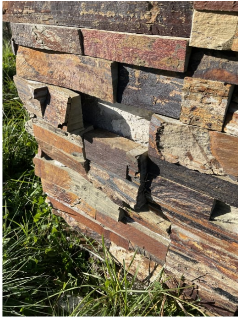
Noe løse forblendingssteiner over tak
