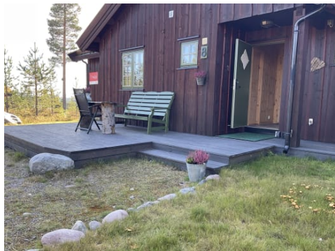
Terrasseplattning tilknyttet inntrukket inngangsparti.
