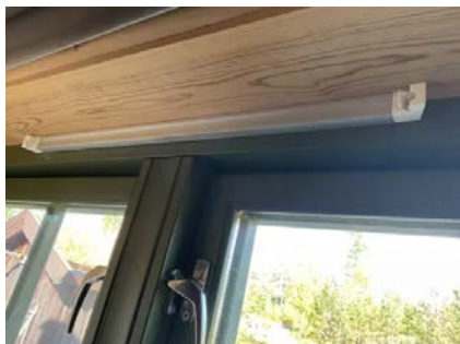
Fritidsbolig med naturlig ventilasjon
