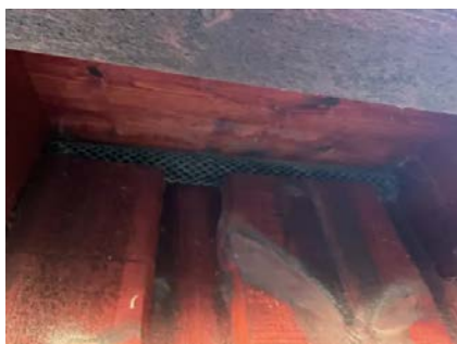
Luftespalter ved raft utført med netlon
