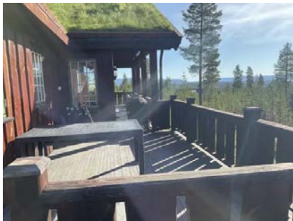
Terrasse mot syd, vid utsikt
