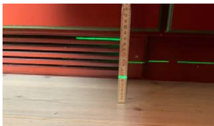
Ingen unormale verdier ved måling
