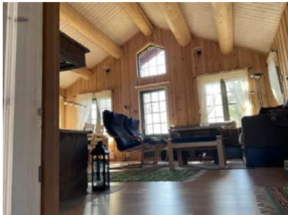
Takkkonstruksjon med innvendige skråhimlinger i stue
