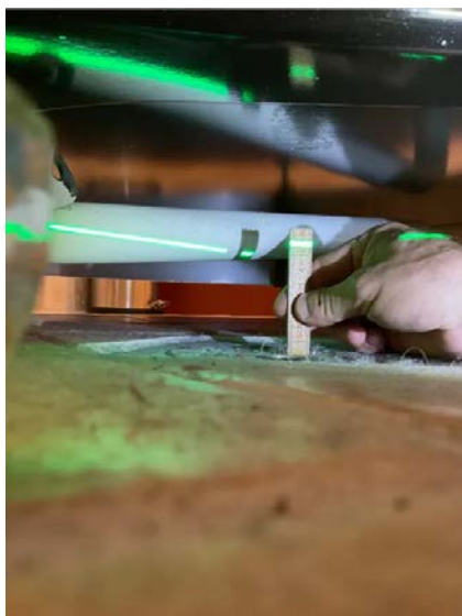
Tilfredsstillende fallforhold til sluk
