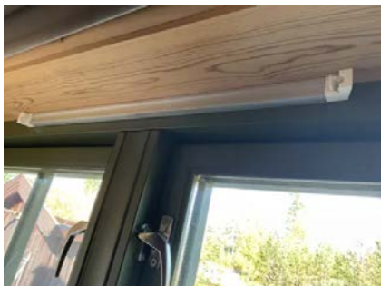
Fritidsbolig med naturlig ventilasjon
