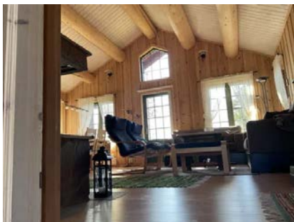
Takkonstruksjon med innvendige skråhimlinger i stue
