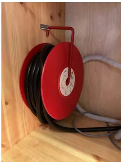
Montert brannslange i benkeskap inne på kjøkken
