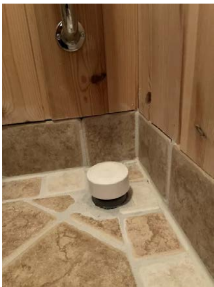
Kloakklufting med kloakkventil
