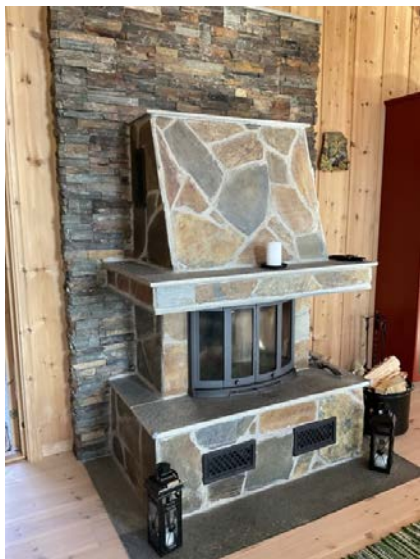
Ildsted med peisinnsetts i murt omramming
