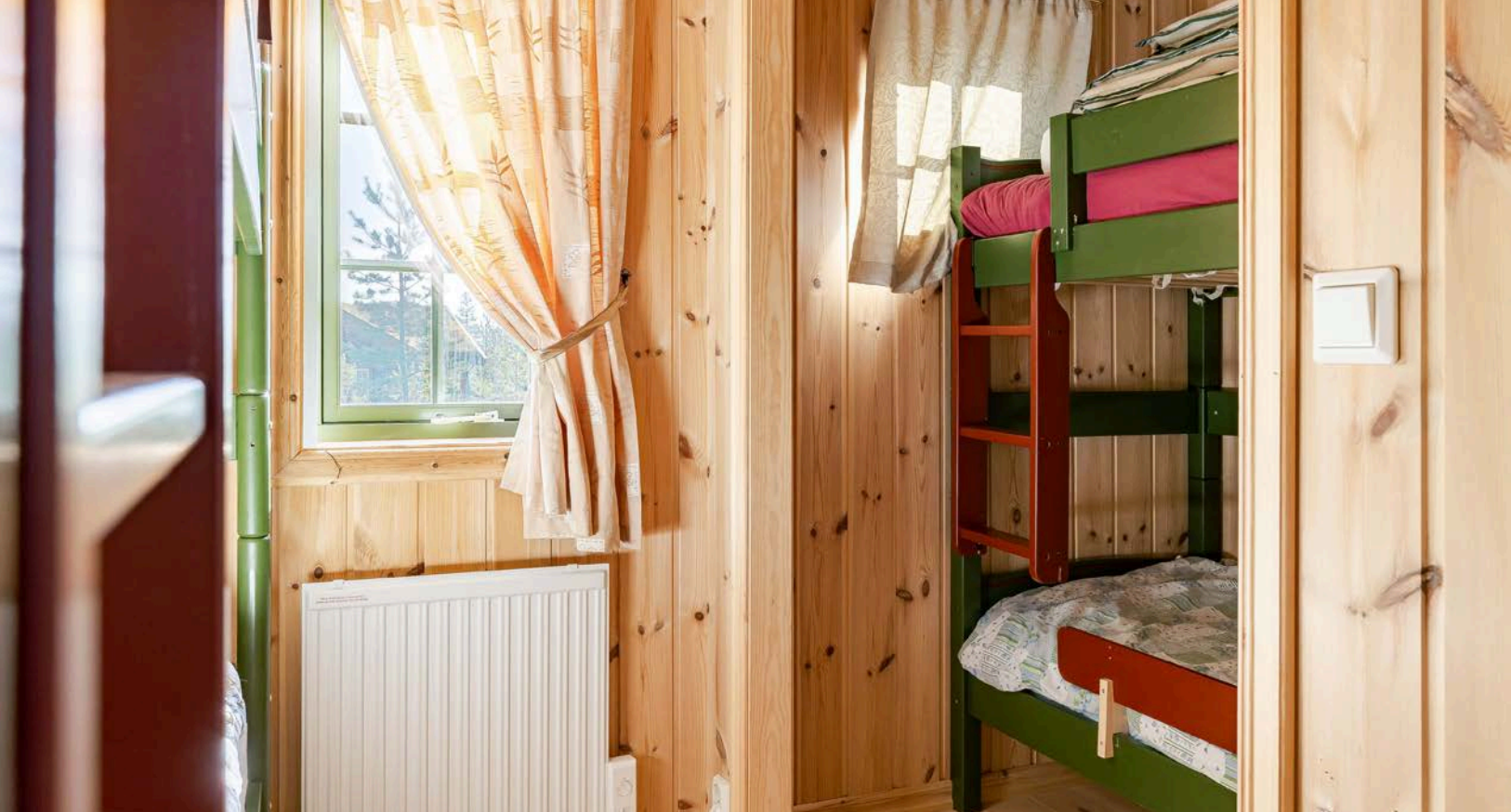
Innenfor soverom 3 er det etablert sengeplasser i en bod. Det gjøres oppmerksom på at dette rommet ikke er godkjent for varig opphold.
