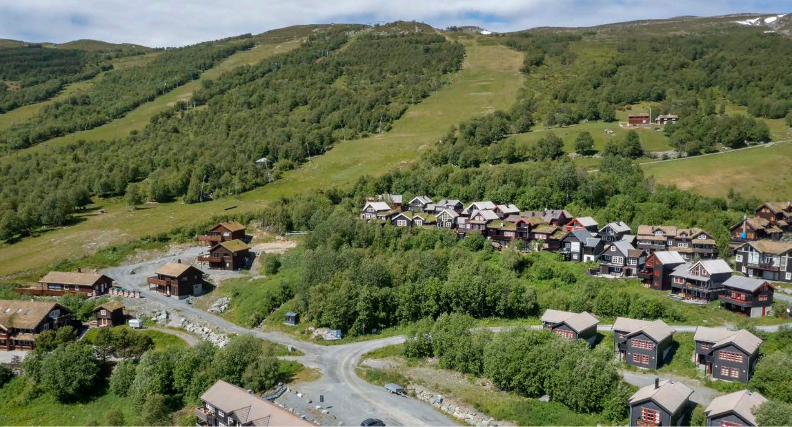
Oversiktsbilde som viser både felt 1 og 2
