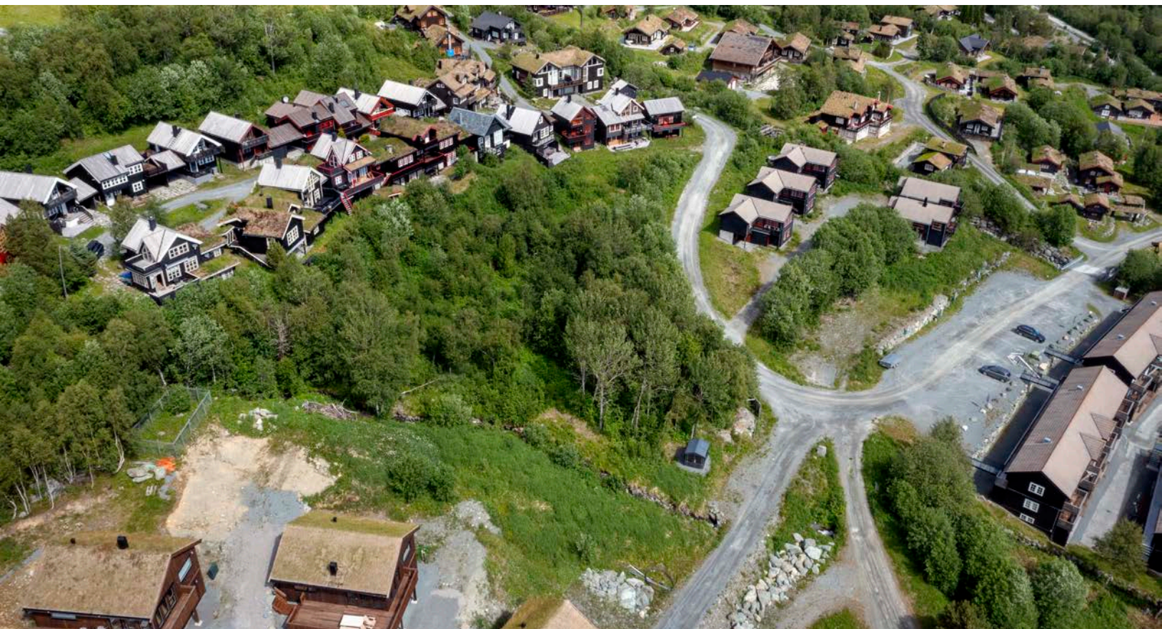
Oversiktsbilde som viser både felt 1 og 2
