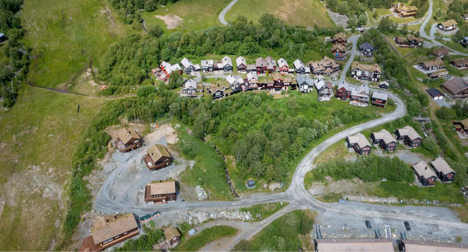
Oversiktsbilde som viser både felt 1 og 2
