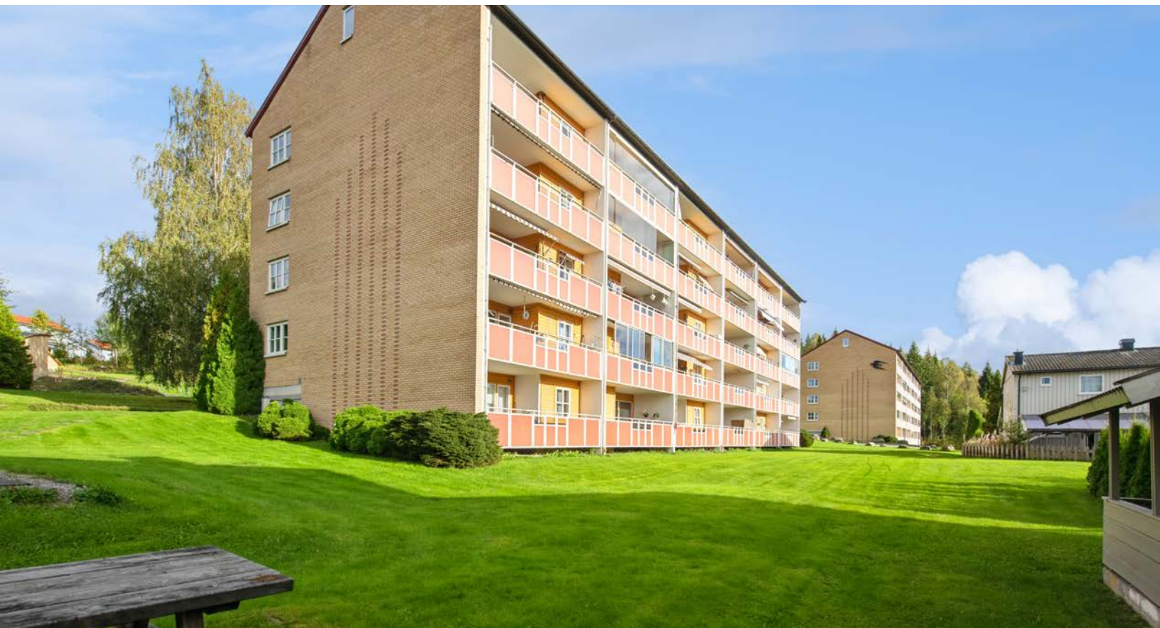
Pent opparbeidede fellesarealer.
