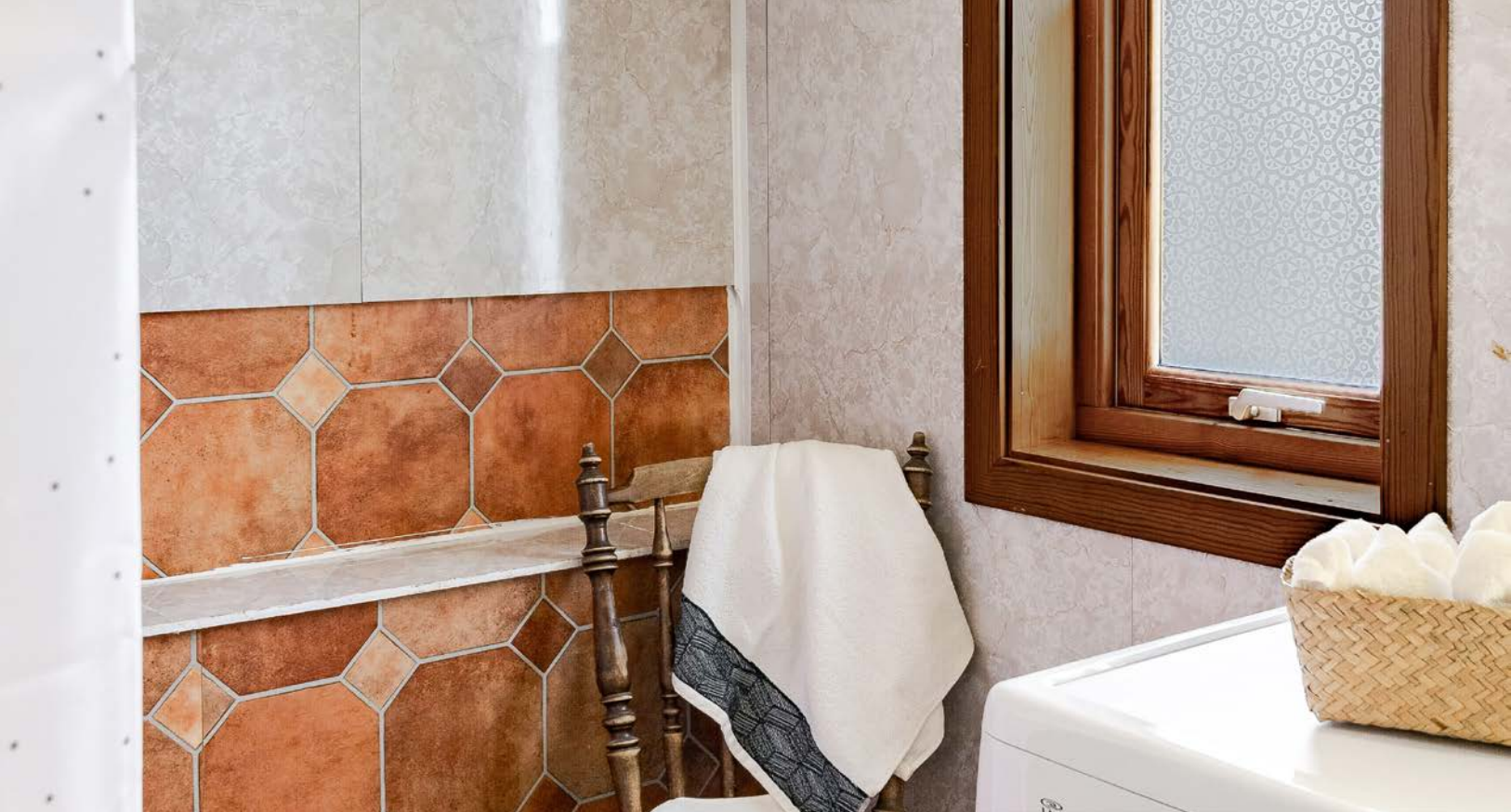
Baderommet har våtromsbelegg på gulv og overflater med malt panel, våtromsplater og vinylbelegg. Oppvarming med panelovn og ventilasjon igjennom el.vifte og vindusventil.
