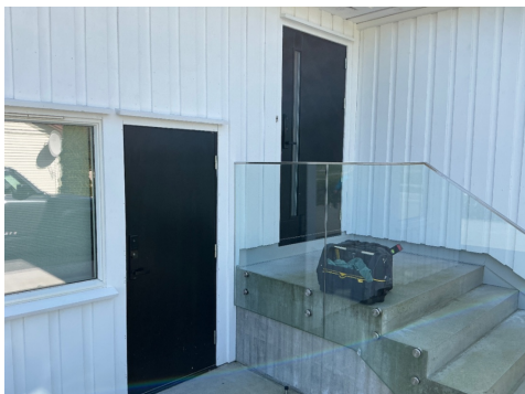
Inngangsdør og garasjedør
