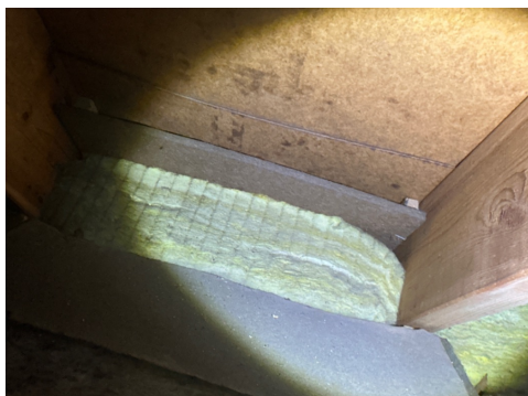
Luftespalte registret etablert på isolert del av skråtak
