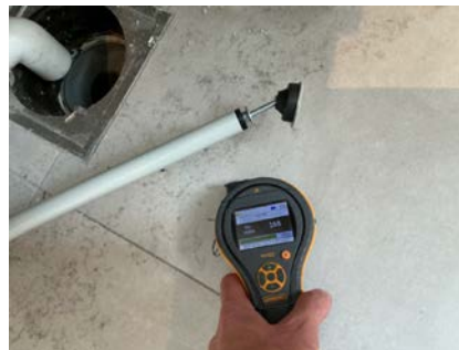
Ingen unormale utslag ved bruk av fuktindikator
