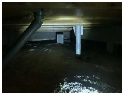
15 år gammel avfukter, med begrenset gjenværende levetid.
