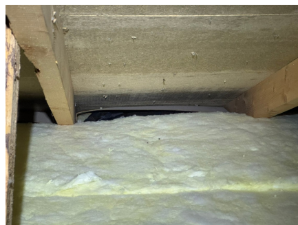
Eksempel på deformert pappkubbing.
