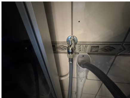
Hull etter tidligere montert utstyr.
