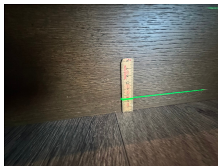
Måling i stuen i 1. etasje.
