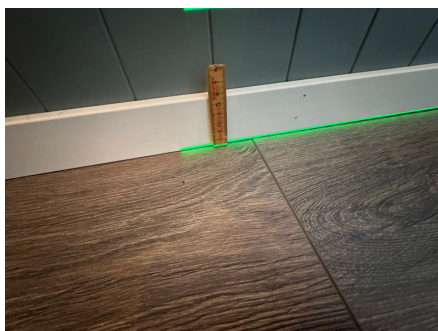
Måling i stuen i 1. etasje.
