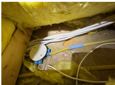
Eksempel på utettheter i dampspennen.
