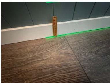
Måling i stuen i 1. etasje.
