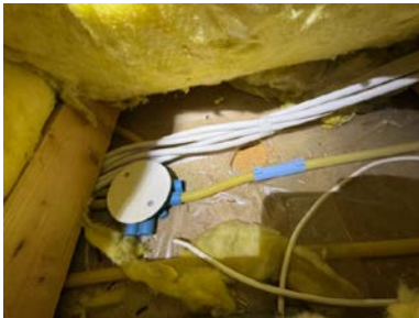
Eksempel på utettheter i dampspennen.
