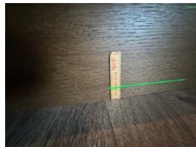
Måling i stuen i 1. etasje.
