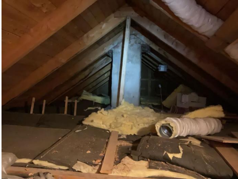
Takkonstruksjon mot nabo uten brannvegg på kaldloft.
