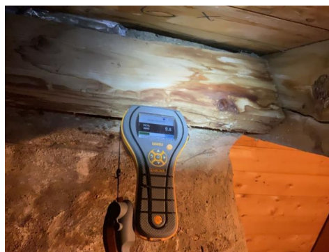
Fuktmåling i tak ved pipe. Ingen unormale verdier.
