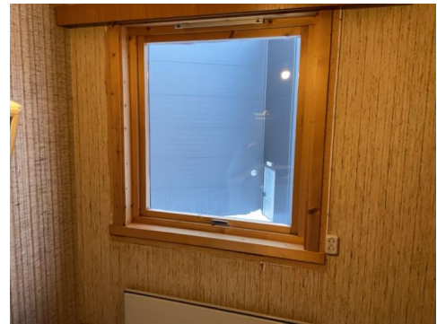
Manglende renovering av vegger etter vindusbytte.
