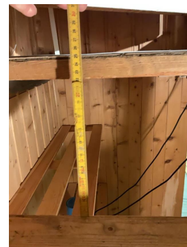
Stor åpning mellom trinn. Her kan det skje ulykker med barn.
