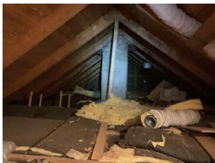
Takkonstruksjon mot nabo uten brannvegg på kaldloft.
