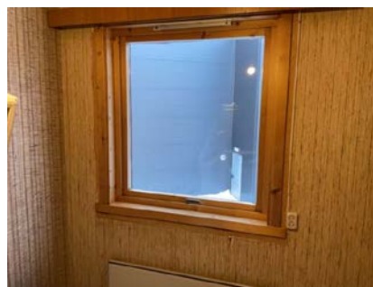
Manglende renovering av vegger etter vindusbytte.
