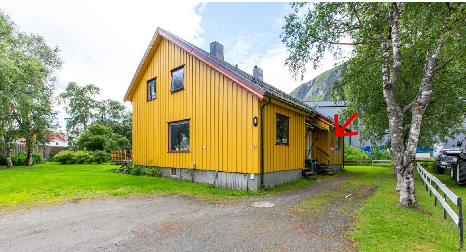
Fasade, inngangen er til høyre
