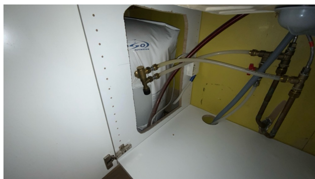
Besiktigelse av bereder.
