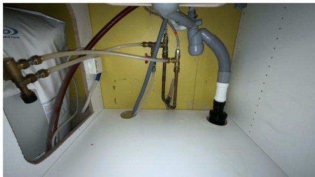
Besiktigelse av røropplegg.
