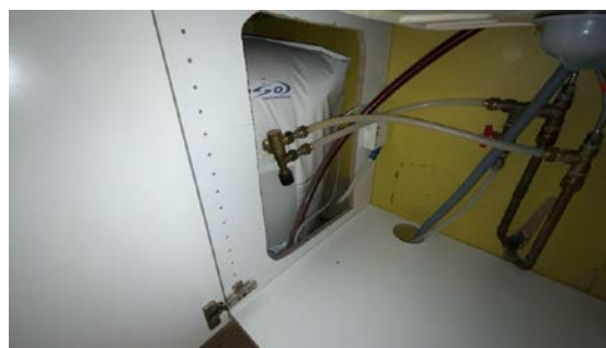
Besiktigelse av bereder.
