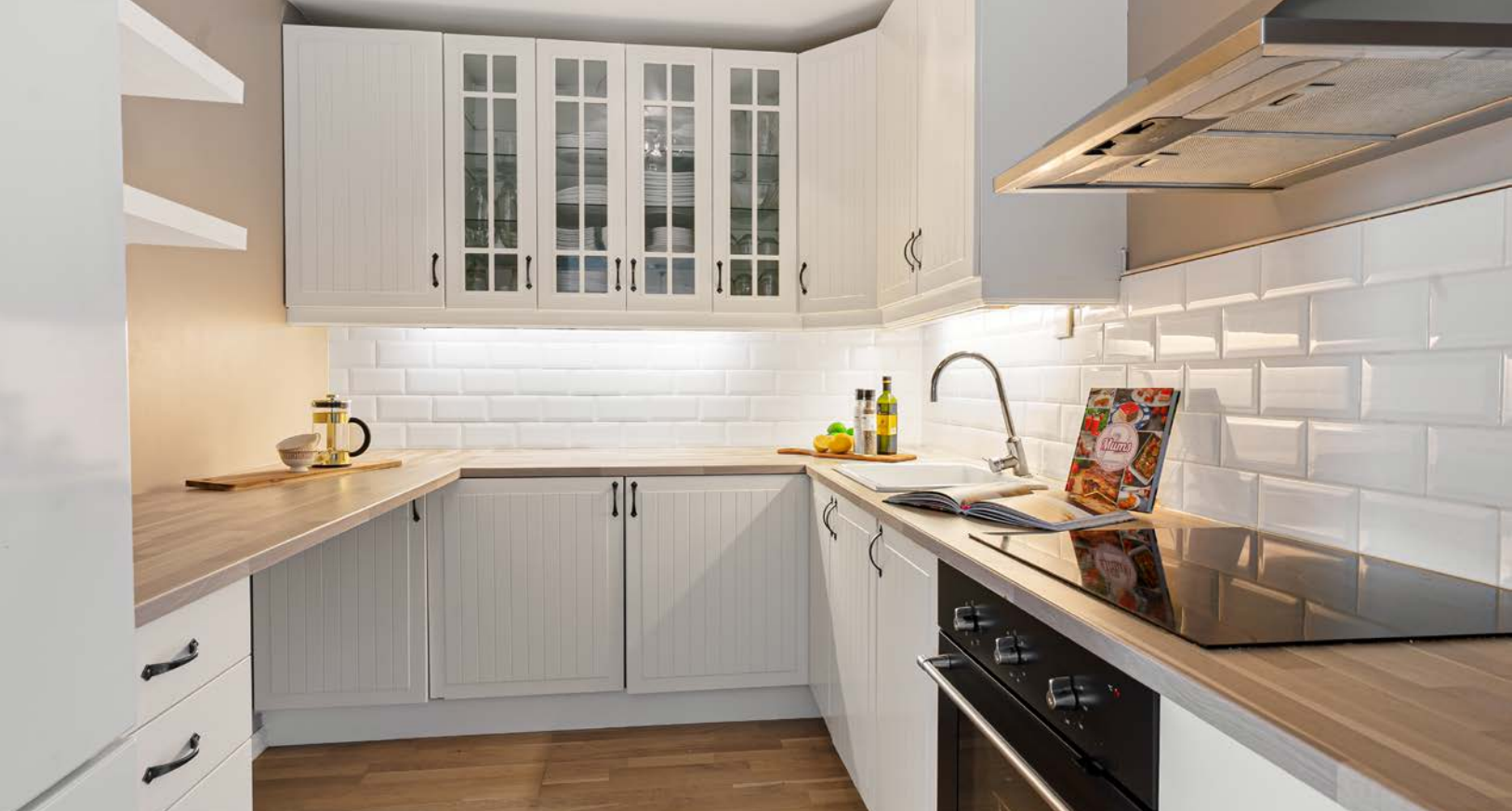
Mellom benk og overskap er det montert praktiske fliser som gir enklere rengjøring av veggflater samt beskytter vegg for vannsøl og matos.
