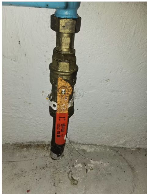
Bilde viser hovedstoppekran.
