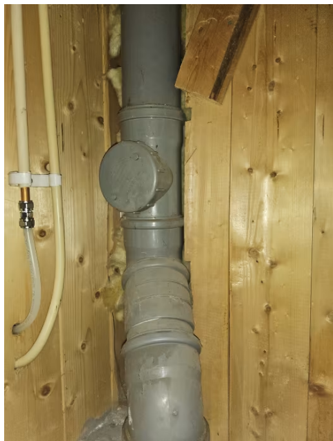
Bilde viser stakeluke i kjeller.
