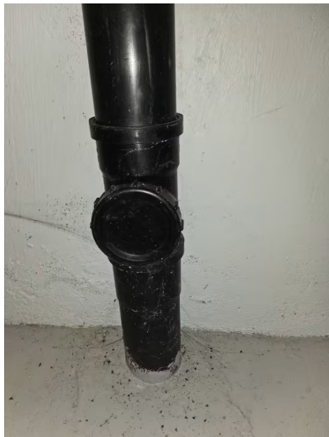
Bilde viser stakeluke i kjeller.
