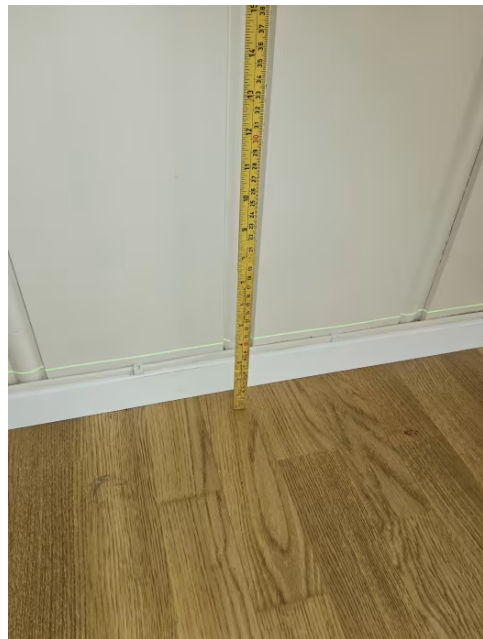
Bilde viser måling av etasjeskiller.
