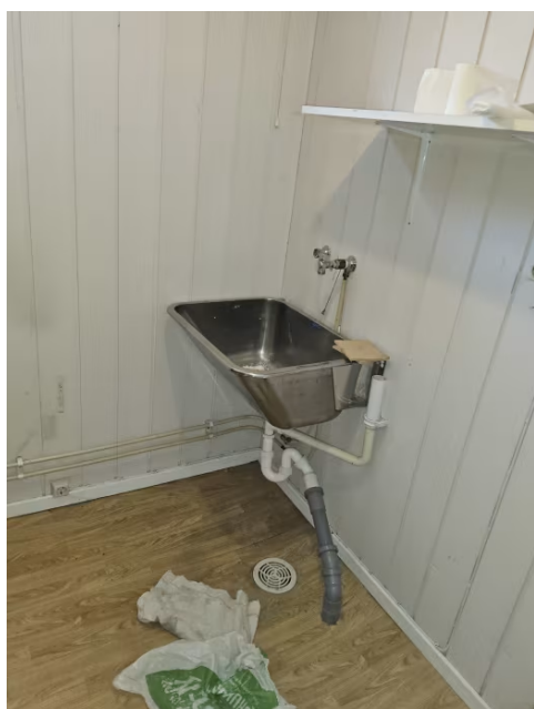
Bilde viser del av vaskerom.
