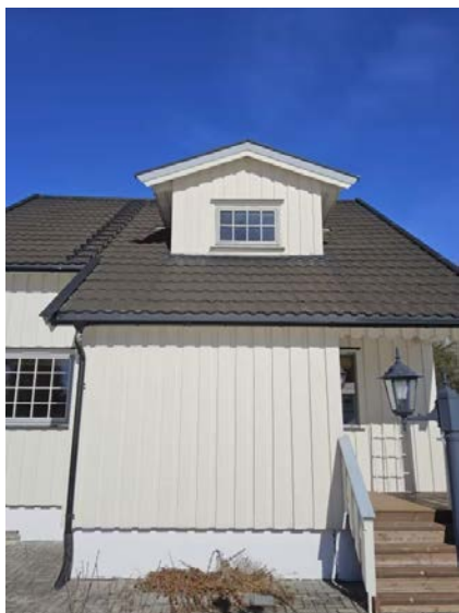
Bilde viser yttervegg mot sør.
