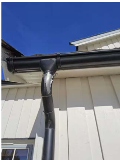
Bilde viser avflassing på taknedløp.
