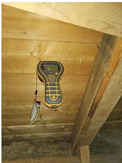
Bilde viser fuktmåling i taktro.
