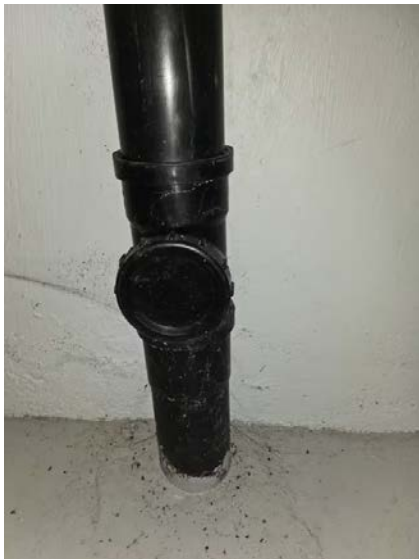
Bilde viser stakeluke i kjeller.
