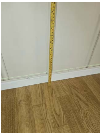
Bilde viser måling av etasjeskiller.
