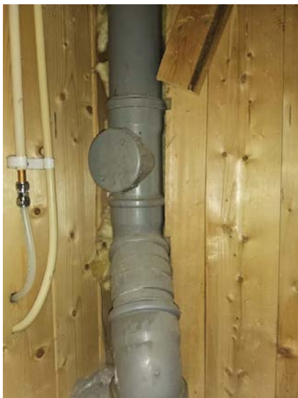
Bilde viser stakeluke i kjeller.
