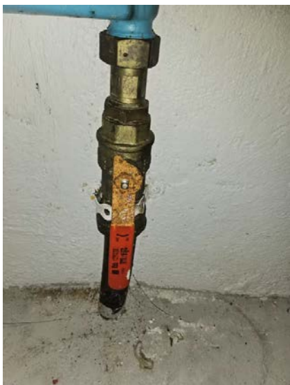
Bilde viser hovedstoppekran.
