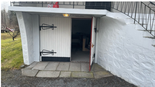
Garasje i underetasje.
