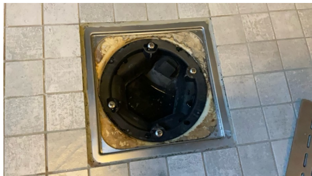
Plastsluk med synlig vinylbelegg.
