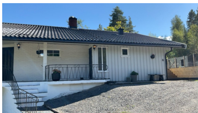
Tømmermannskledning og teglsteinfasade.
