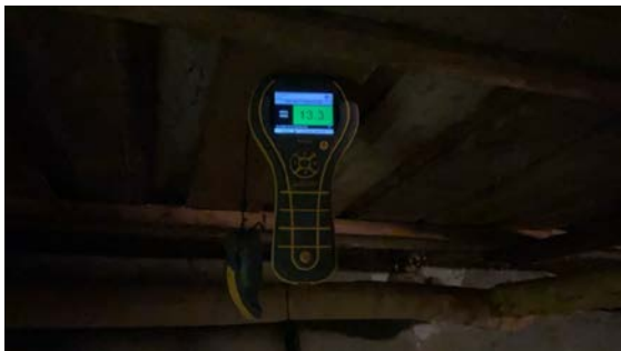
Fuktmåling i etasjeskille i krypkjeller uten unormale resultater.
