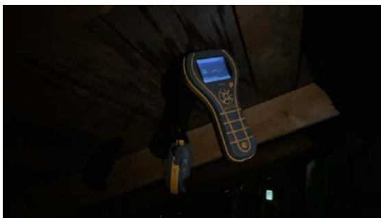
Det er utført fuktmåling med pigger uten unormale resultater i fuktskjolder.
