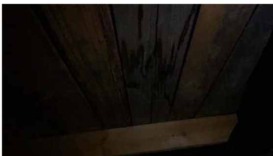
Fuktskjolder i taktro.
