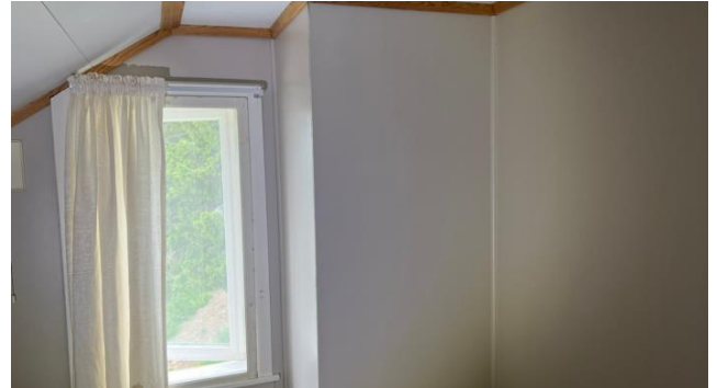
Innkledd pipe på soverommet
