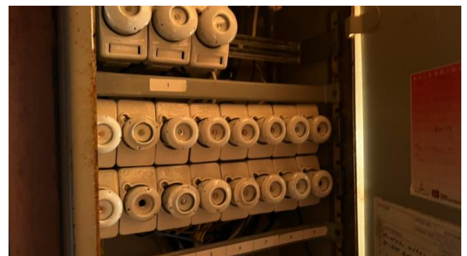
Sikringskap med skrusikringer
