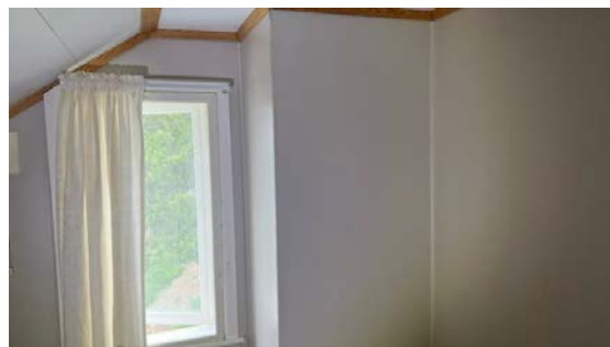
Innkledd pipe på soverommet
