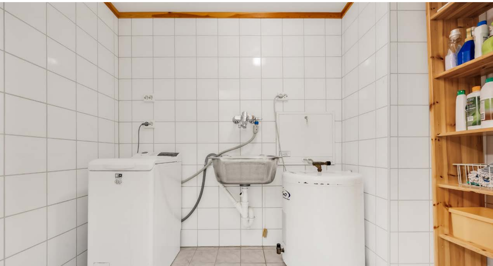
Vaskerommet er utstyrt med skyllekum i tillegg til opplegg for vaskemaskin.
