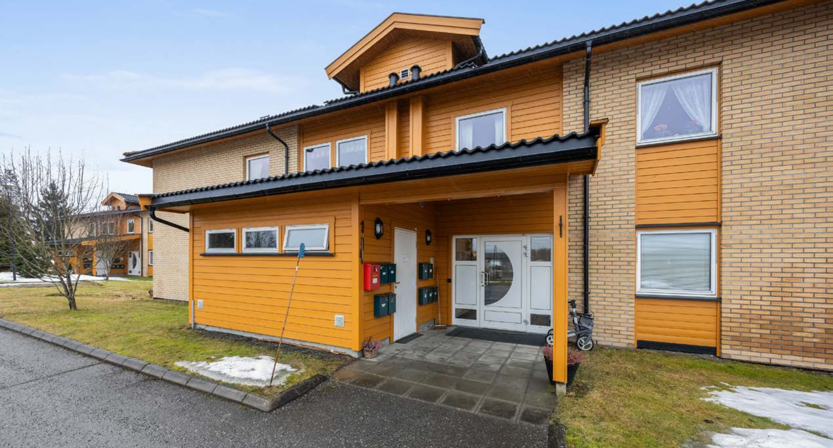
Det er enkel adkomst via felles oppgang med heis.
