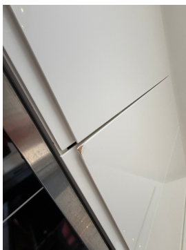
Noe mindre skader på enkelte fronter
