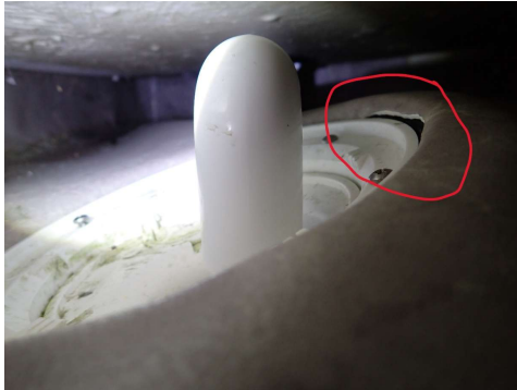
Viser utetthet rundt gulvsluk.
