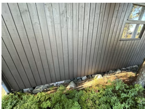
Det er begrenset besiktigelsesmuligheter for inspeksjon av kryperom.
