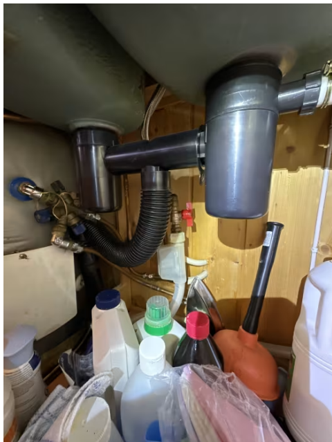
Viser vann og avløpsinstallasjoner under kum.
