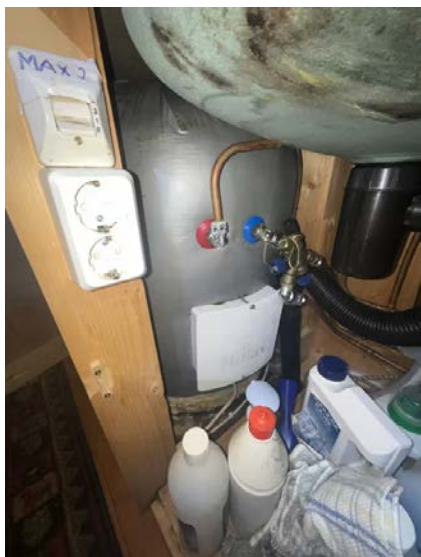
Viser plassering av bereder i kjøkkenskap.
