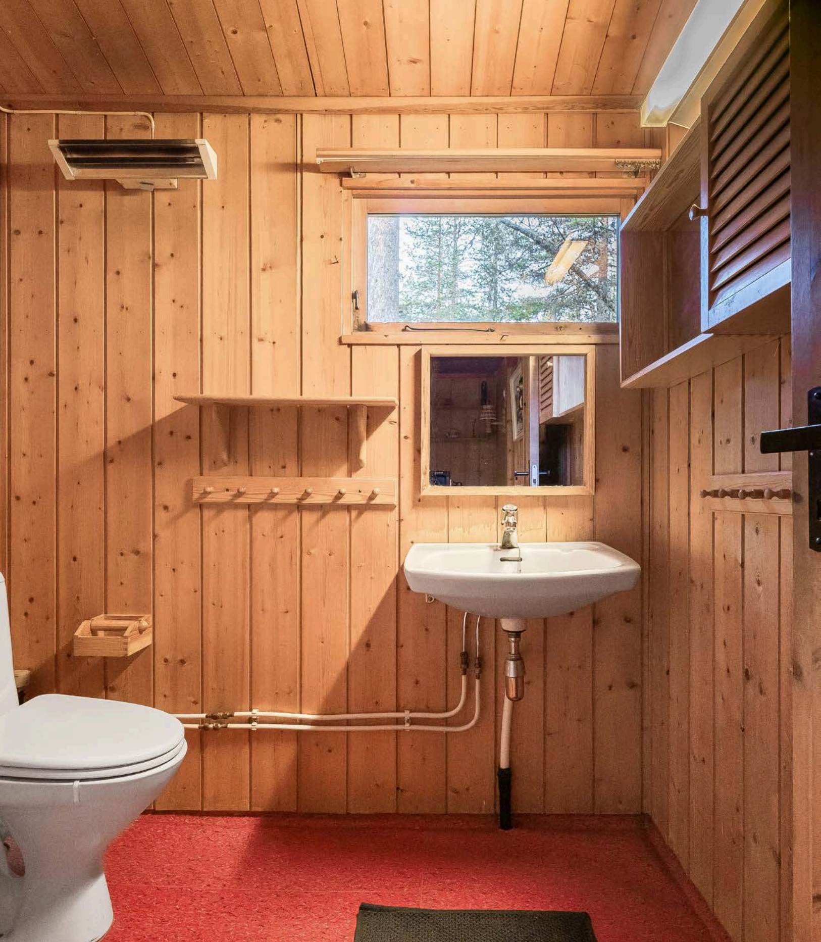
Hytta har et eldre baderom som må rehabiliteres. Baderommet har belegg på gulv og overflater med trepanel. Baderommet er utstyrt med vegghengt servant, dusjkabinett og gulvstående toalett. Oppvarming med stråleovn.
