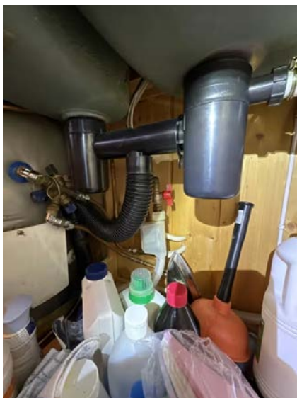
Viser vann og avløpsinstallasjoner under kum.
