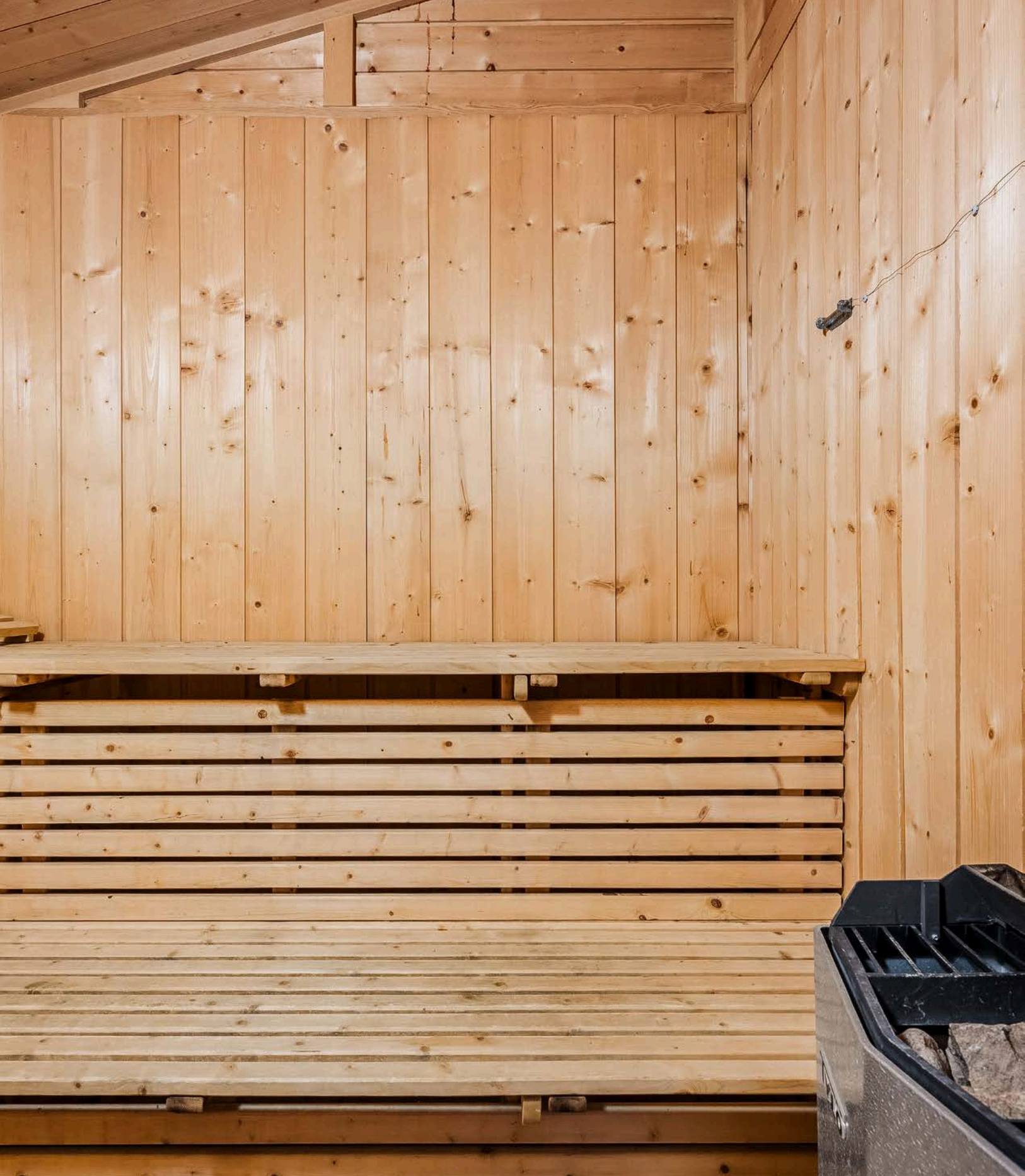
Fra baderommet er det adkomst til en badstue med plassbygde sittebenker og badstueovn av type Tylö.
