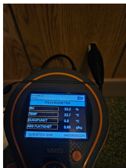
Måling av relativ luftfuktighet i lukket veggkonstruksjon mellom gang og bad.
