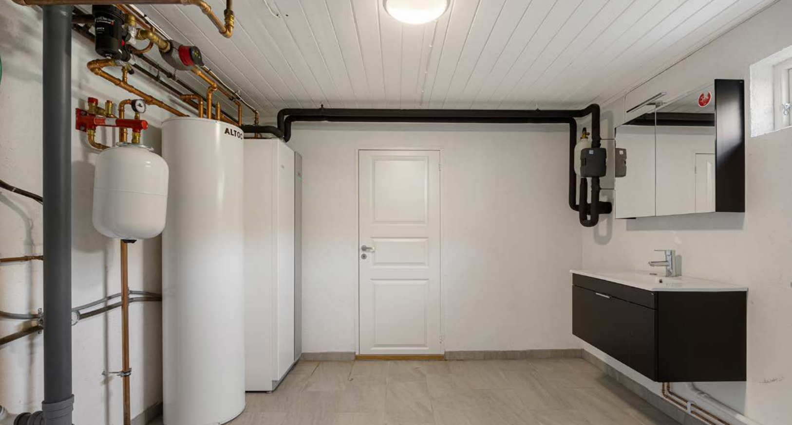
Et sort servantskap med skuffer er plassert under et speilskap med belysning.
