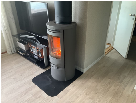
Vedovn med stålpipe.
