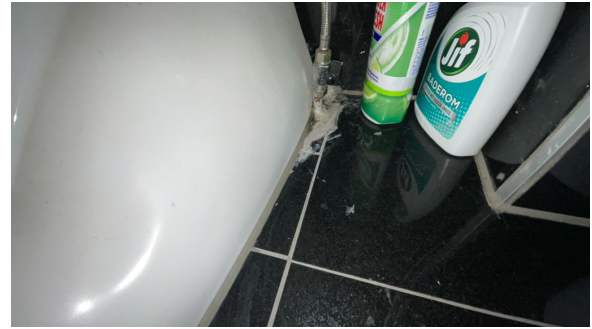
Rørgjennomføring i gulv.
