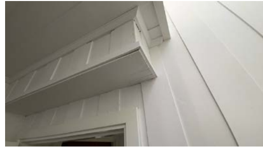
Nedkassing for rørgjennomføring.
