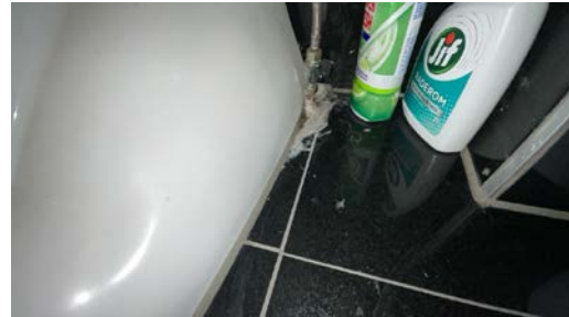
Rørgjennomføring i gulv.
