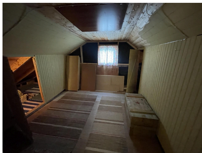
Uferdig rom over tidligere terrasse på tak
