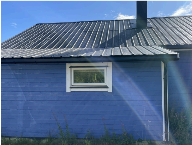
Befaring kun fra bakkeplan – ikke sikker tilgang til tak. Befaring kun fra bakkeplan – ikke sikker tilgang til tak.
