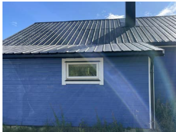
Taket er ikke inspisert på nært hold pga. manglende takstige.
