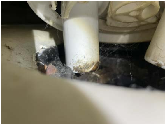
Tettesjikt ikke klemt til sluk.
