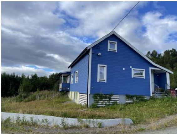
Betongsøyler/pilarer har mindre skjevstilling i vertikal retning.
